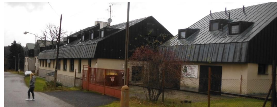
Pohled na areál zvenčí
